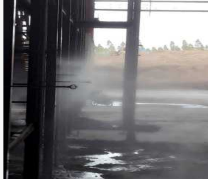
ระบบหัวพ่นน้ำ (Sprinkler) รอบกองชานอ้อย ทั้งหมด
